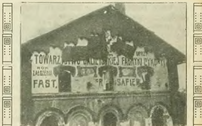
Fabryka cykoryi przy linii kolejowej kolo Przemyśla. Dwugłowy orzeł austriacki zakryty przez Moskali szmatami
