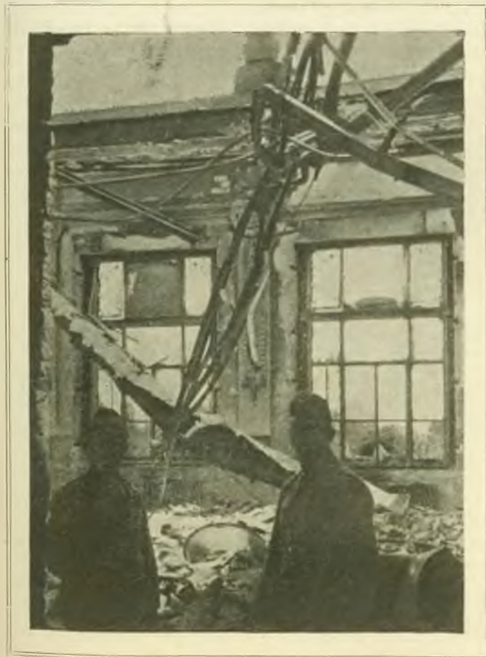
Część zburzonego przez Moskali dworca kolejowego we Lwowie.
