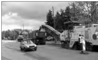
Remont ul. Lwowskiej
