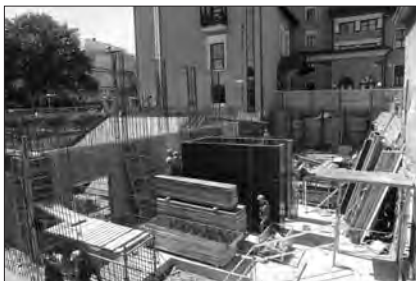
Budowa galerii – fundamenty posadwiono siedem metrów w głąb ziemi
