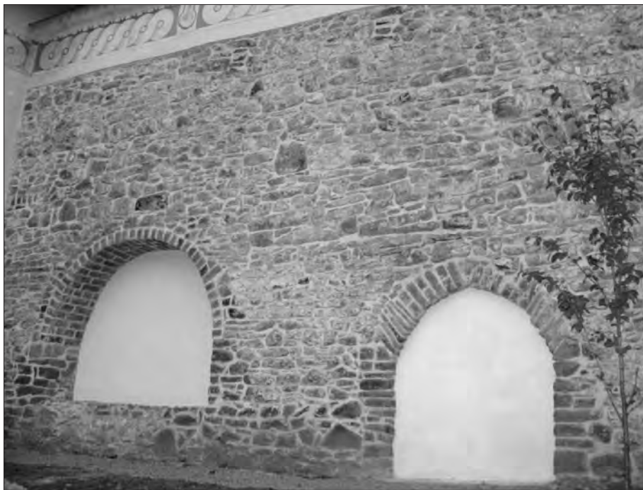
Zamurowane otwory w murze klasztornym
