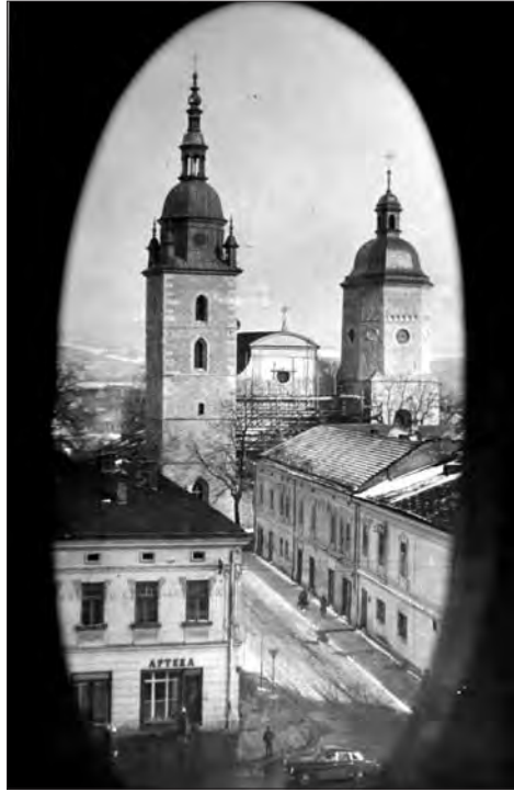
Kolegiata w Nowym Sączu podczas remontu
