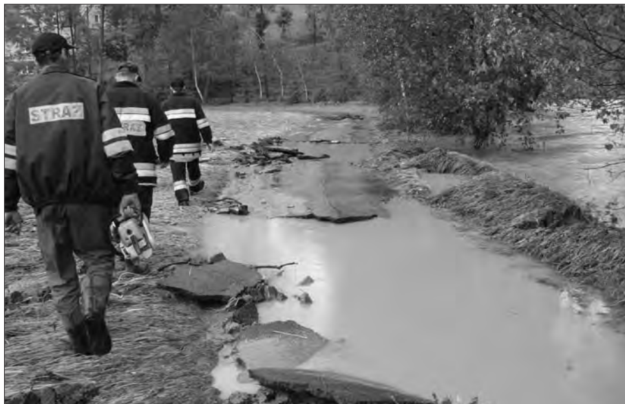
Zniszczona droga gminna w Ryglicach (UMiG w Ryglicach)
