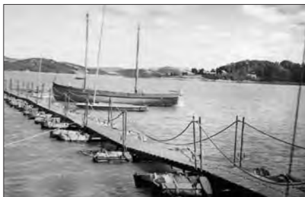
Rok 1964 – pomost w przystani YC Ziemi Sąddeckiej LOK w Tęgorborzu. Pływaki wypełnione słomą
