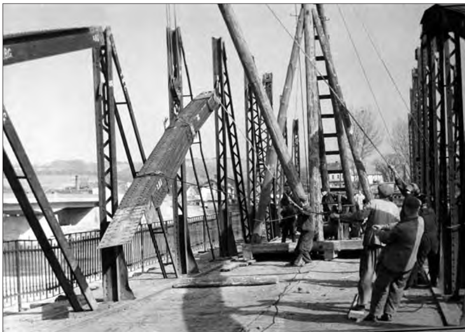
Rozbiórka starego mostu
