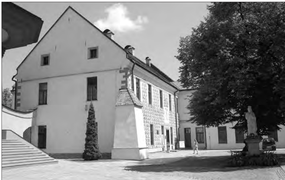
Dom Kapelana na dziedzińcu zewnętrznym
