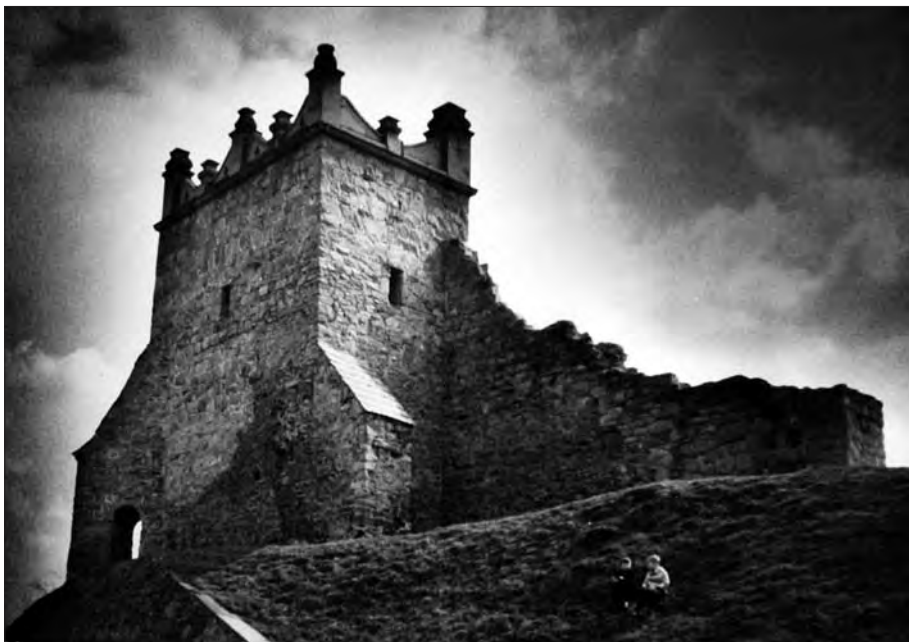
Basztka Kowalska po odbudowie
