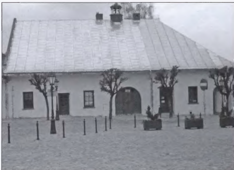
Odremontowany budynek SHP – Rynek 17, fot. SHP.
