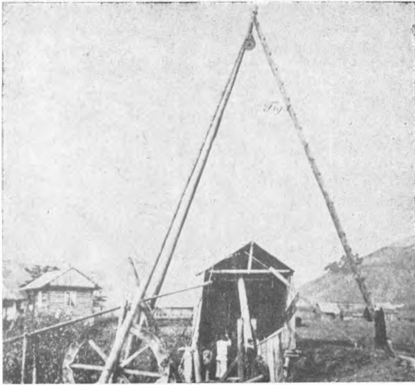
2. Wiercenie udarowe ręczne w Kłęczanach (rok 1887)
