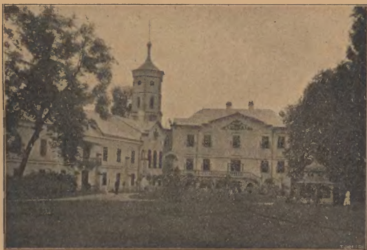
Zamek w Nawojowej w obecnym stanie.
