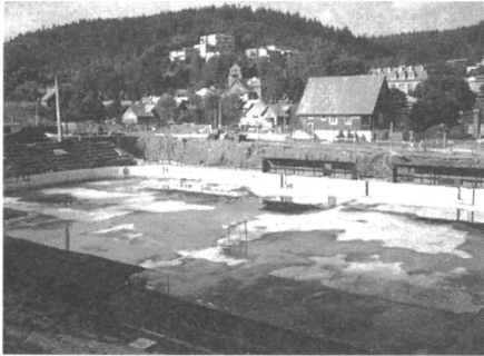
Prace przy zadaszaniu krynickiego lodowiska
