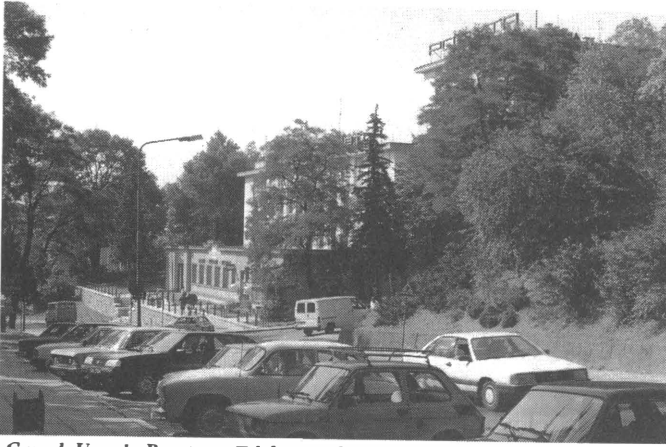
Gmach Urzędu Poczta-Telekomunikacyjnego przy ul. Zdrojowej obecnie
