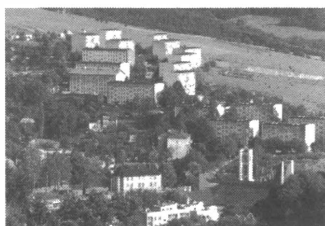
Widok na ul. Źródłaną (Osiedle i domy poniżej) fot. A. Błażowski
