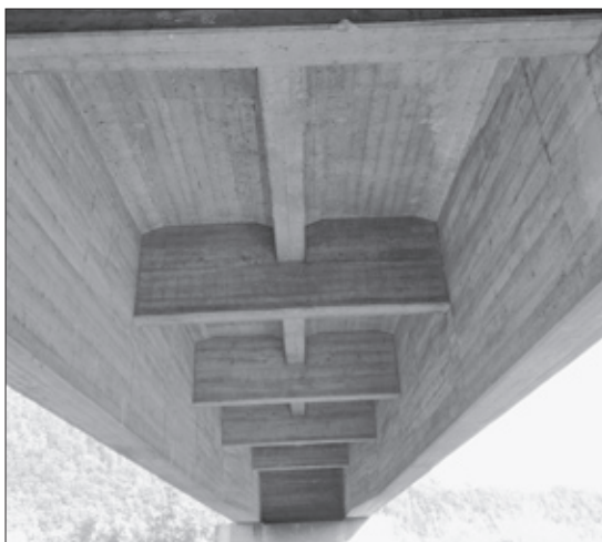
Widok na belkową konstrukcję mostu
