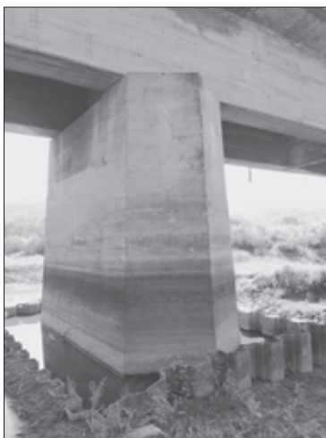
Filar mostu z wystającą z ziemi ścianką Larsena, służącą podczas budowy do zabezpieczenia wykopu
