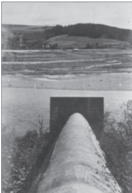
Jeden z przepustów wykonany przed wojną na trasie planowanej drogi wzdłuż brzegu Dunajca, fot. ze zbiorów autora
