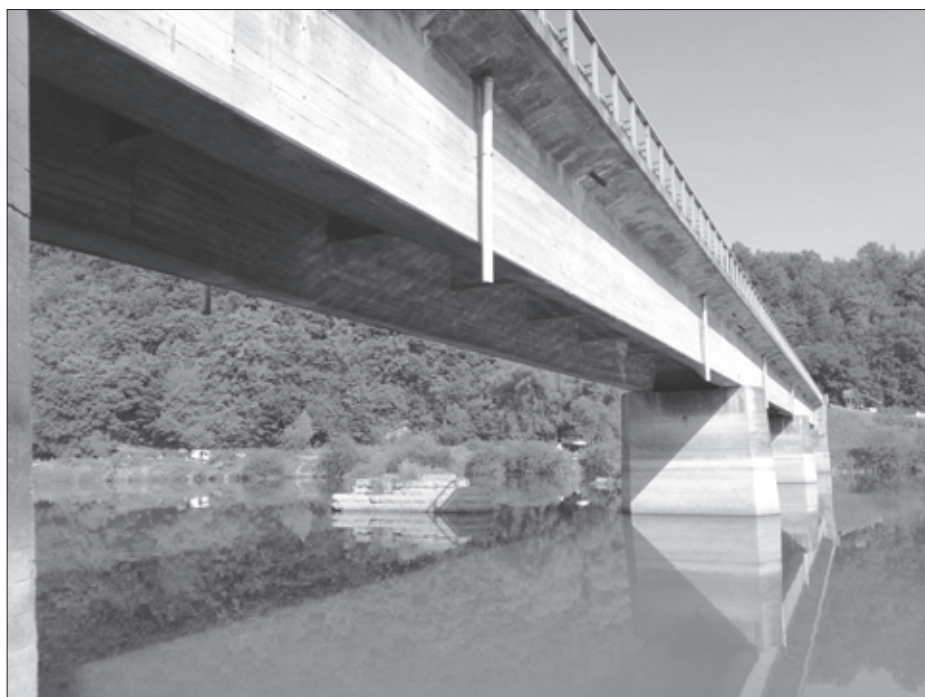
Most w Kurowie, widoczne kamienne filary starego drewnianego mostu spalonego 4 września 1939 r.
