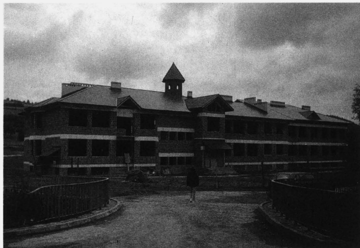
...i nowy, w trakcie budowy.
