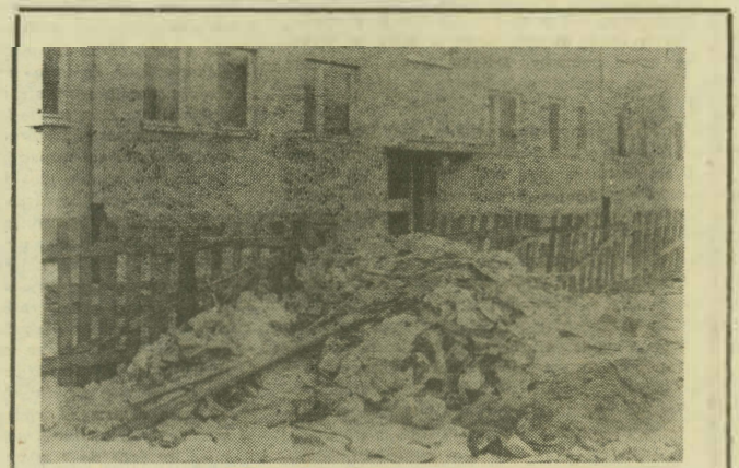
Takie oto „remanent” pozostawili po sobie budowlani z Nowosądeckiego „Kombinatu Budownictwa, wnosząc blok patronacki ZSMP w Muszynie, przy ul. Świerczewskiego. Półki co, śnieg przykrywa rumowisko, ale czają się pod nim istne pułapki na przechodniów. Kto, proszę PT Budowlanych, ma z tym zrobić porządek? Fot. STANISŁAW ŚMIFRACIAK
