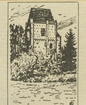
Wieża zamku Górków w Szamotułach, w której więziona była Halaśka.
